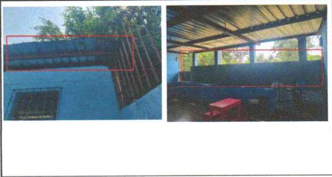
**Sustitucion de lamina acanalada , Mantenimiento de estructura portante**
