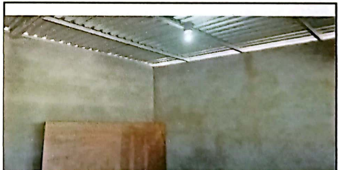
Foto 6: VISTA INTERIO DE MODULOS DE AULAS CON REPELLO FINALIZADAS
