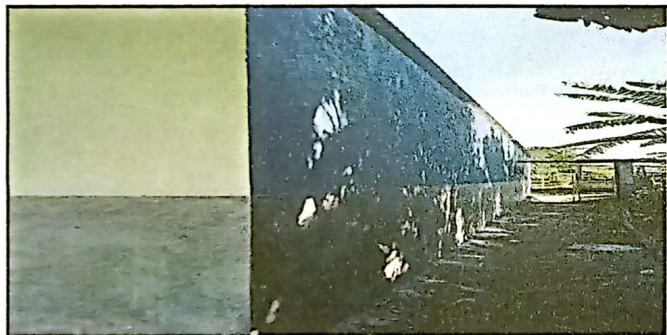
Foto 3: VISTA EXTERIOR DE REMOZAMIENTO DE MUROS CON REPELLO
