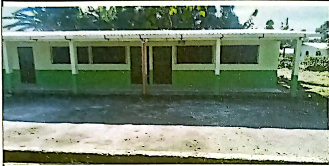
Foto1: VISTA FACHADA LAMINA COLOCADA AL 100%
