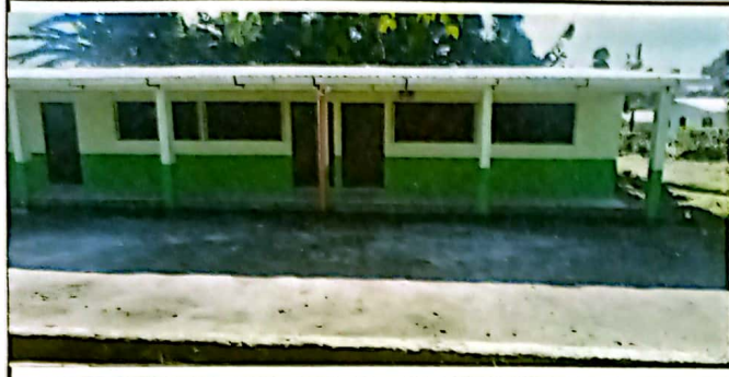
Foto1: VISTA FACHADA LAMINA COLOCADA AL 100%
