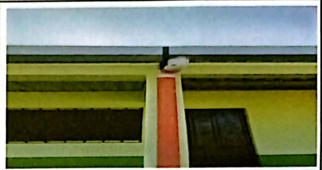
Foto 2: VISTA INSTALACION DE CANAL PLUVIAL FINALIZADO
