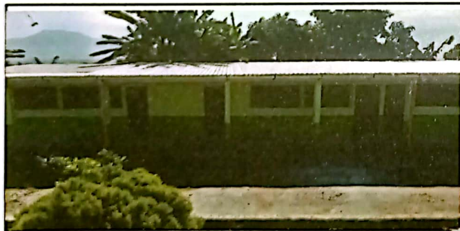
Foto 5: VISTA COMPLETA DE PROYECTO DE REMOZAMIENTO FINALIZADO AL 100 %
