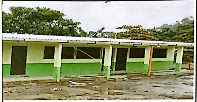
Foto 2: FINALIZA COLOCACIÓN DE LAMINAS
