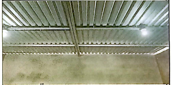
Foto 4 : INSTALACIÓN ELECTRICA, ILUMINACION Y FUERZA
