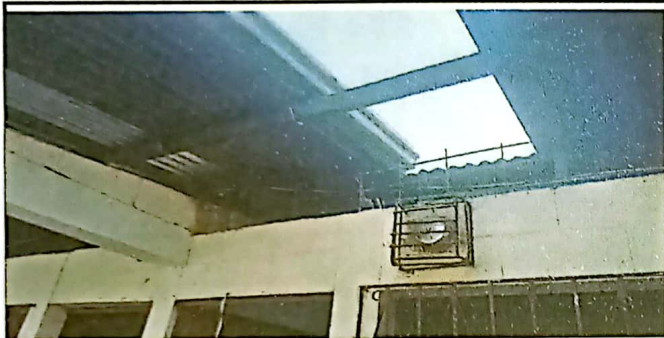
Foto 3: INSTALACION ELECTRICA,ILUMINACION Y FUERZA
