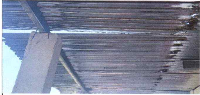
suministro e instalación de cubierta metalica lamina troquelada calibre 26.
