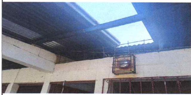
instalación electrica iluminación y fuerza dentro en todo el modulo existente.
