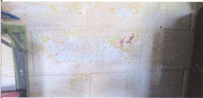
suministro de materiales + repello de aulas existentes modulo completo.
