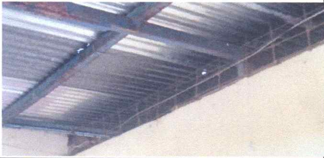
suministro e instalación de estructura portante con costanera de 4*2 galvanizada
