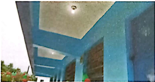
Foto 5: VISTA DE INSTALACIONES ELECTRICAS
