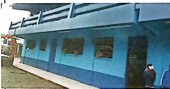
Foto 4: VISTA DEL EDIFICIO PINTURA EXTERIOR FINALIZADA AL 100%
