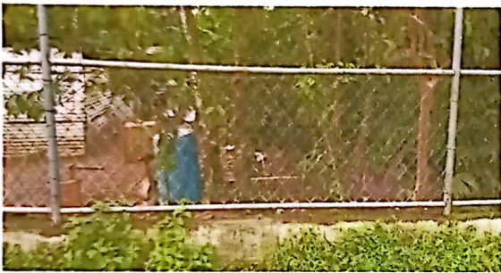
Foto 3: VISTA DE MALLA PERIMETRAL REPARADA
