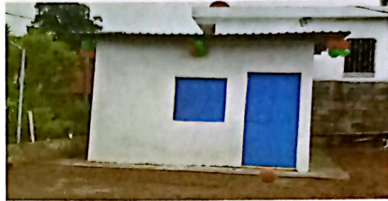
Foto 2: VISTA DE COCINA FINALIZADA AL 100%
