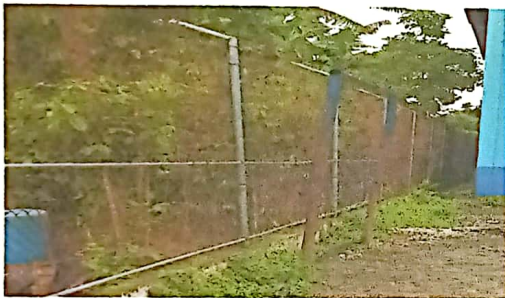
Foto 3: MANTENIMIENTO DE MALLA PERIMETRAL
