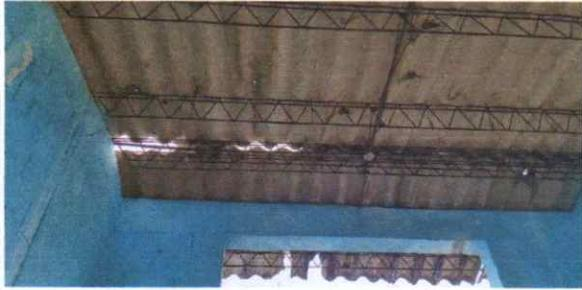
Sustitucion de lamina y manteminiendo ala estructura en modulo de gradas.
