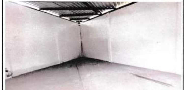
Foto 4: SUMINISTRO E INSTALACION LAMINA EN LA COSINA
