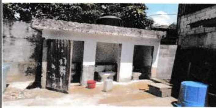
Foto 3: Mantenimiento de sanitarios
