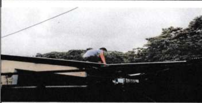
FOTO 1: Suministro e instalacion de lamina troquelada pasillo
