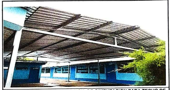
Foto 2: SUMINISTRO E INSTALACION DE CIMENTACION PARA TECHO DE PATIO, ESTRUCTURA METALICA DE TECHO DE PATIO Y CUBIERTA DE LAMINA TROQUELADA EN PATIO FINALIZADO AL 100%
