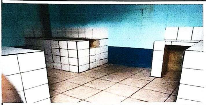
Foto 3: VISTA DE MANTENIMIENTO DE COCINA CON SUSTITUCION DE ESTUFA, SUMISTRO E INSTALACION DE PISO, CHIMENEA Y SUMINISTRO E INSTALACION DE MESA DE TRABAJO EN LA COCINA FINALIZADO
