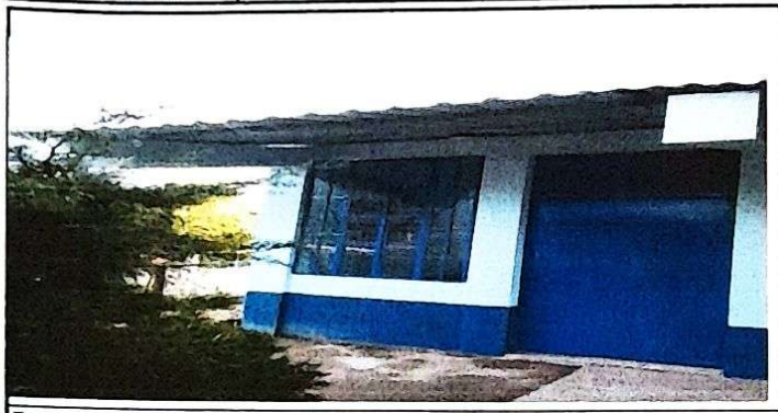
Foto1: SUMINISTRO E INSTALACION DE ESTRUCTURA METALICA DE Techo EN AULA AL 100%
