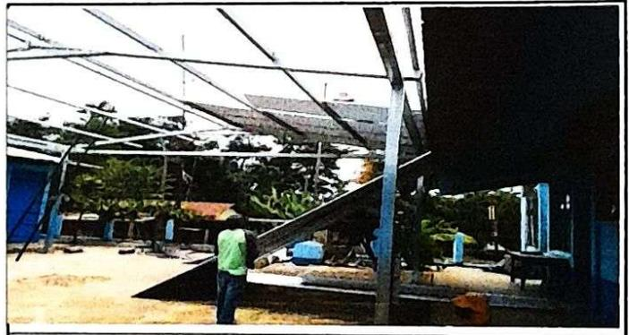
Foto 4: SUMINISTRO E INSTALACION DE CUBIERTA DE LAMINA TROQUELADA EN PATIO
