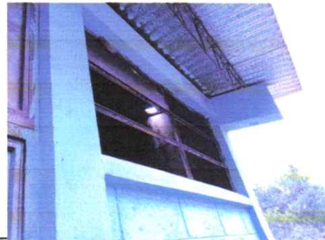
Suministro e instalación de estructura metálica en cocina
