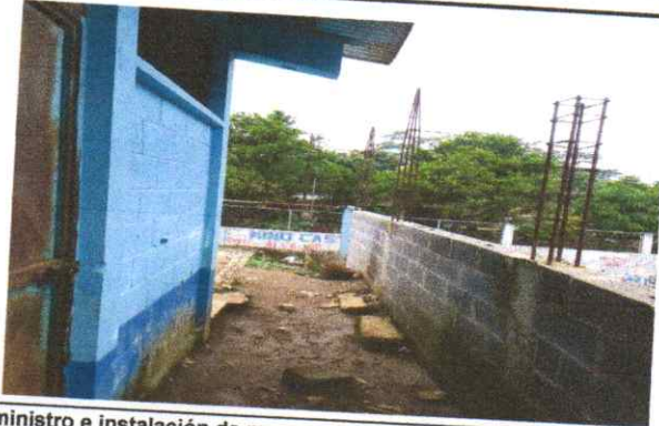
Suministro e instalación de muro mojinete de block para cocina
