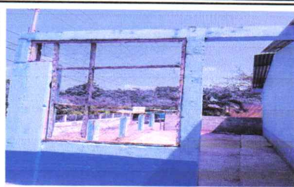
Suministro e instalación de cubierta de lámina troquelada en aula
