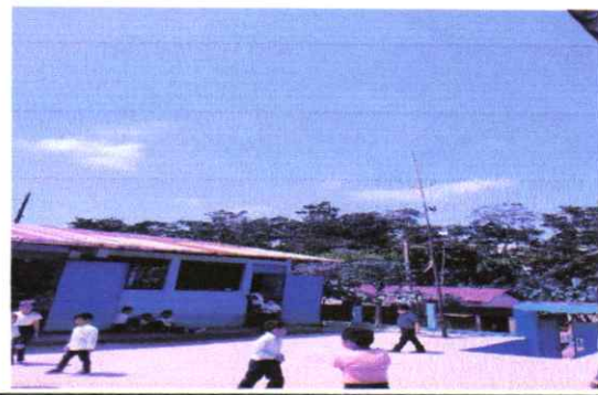
Suministro e instalación de estructura metálica de techo de patio
