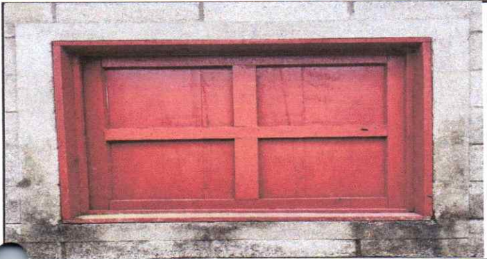
FABRICACION E INSTALACIÓN DE VENTANAS DE METAL, DE 1*1.50 CON CASADORES
