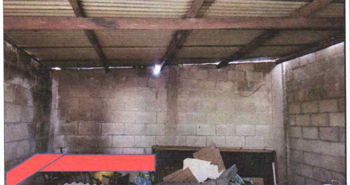
SUMINISTRO DE MATERIALES Y FABRICACIÓN DE ESTUFA, PILA Y MESA DE CONCRETO
