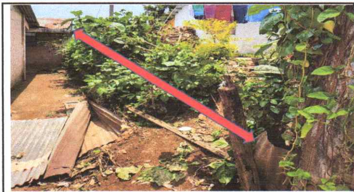
SUMINISTRO DE MATERIALES E INSTALACION DE MURO PREFABRICADO DE 11.40 ML * 2.80 M
