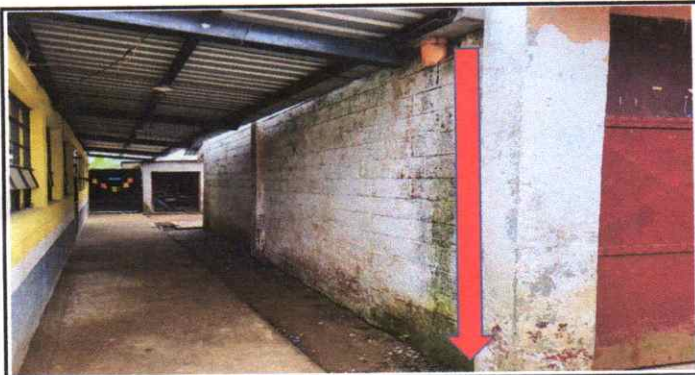
SUMINISTRO E INSTALACIÓN DE CANAL PLUVIAL DE 0.20*0.25
