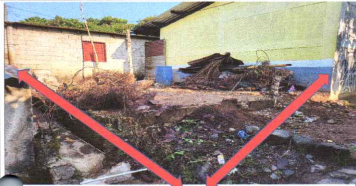
SUMINISTRO DE MATERIALES E INSTALACION DE MURO PREFABRICADO DE 12.35 ML * 2.80 M
