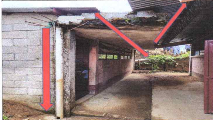
SUMINISTRO E INSTALACION DE CANAL PLUVIAL
