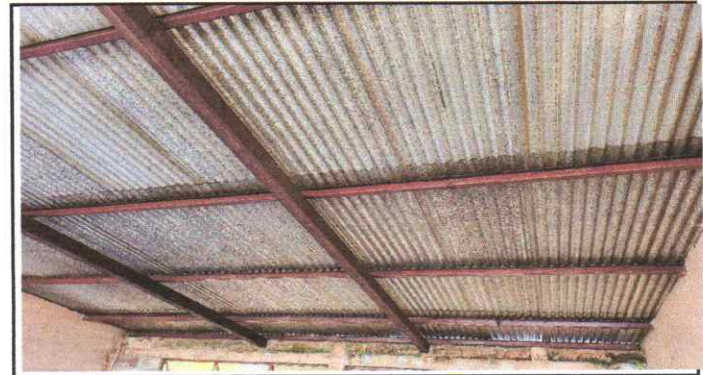
SUMINISTRO E INSTALACION DE CUBIERTA METALICA CON LAMINA TROQUELADA CALIBRE 26
