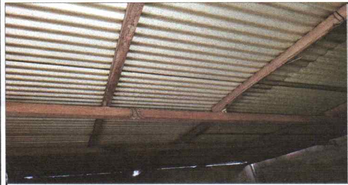
SUMINISTRO E INSTALACION DE ESTRUCTIURA PORTANTE CON COSTANERA DE 3*2 GALVANIZADA
