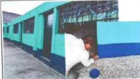
Proceso de aplicación de pintura color azul naval para los socacos de la escuela
