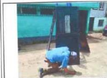
Arreglo y pintura de las puertas luego se les cambio la chapa
