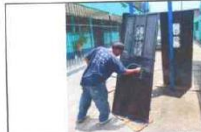
Proceso de arreglo y pintura de las puertas tanto de la central del establecimiento como en el anexo
