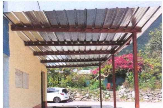
Foto 10: Sustitución de estructura portante de techo de cocina.
