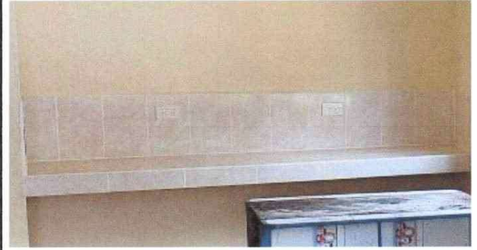
Foto 8: Sustitución de tomacorrientes.
