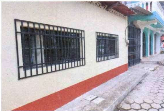
Foto 3: Sustitución de balcones
