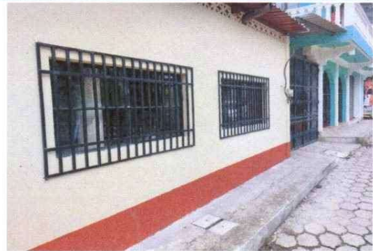
Foto 2: Sustitución de ventanas.
