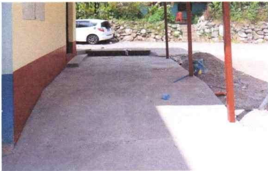
Foto 9: Sustitución de torta de concreto de patio.
