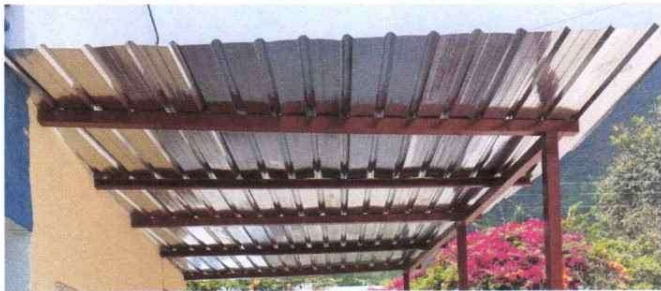
Foto 11: Sustitución de lámina troquelada calibre 26.
