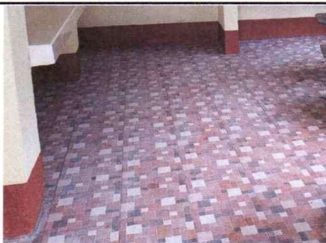
Foto 5: Sustitución de piso de concreto de cocina
