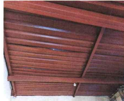
Foto 4: Mantenimiento de estructura y lámina con pintura anticorrosiva.
