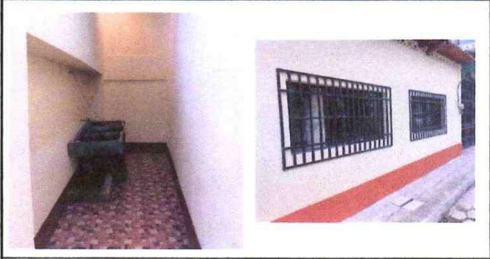
Foto 13: Suministro y aplicación de pintura en muros interiores y exteriores.
