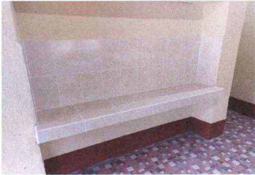
Foto 7: Suministro e instalación de mesas de trabajo de cocina.
