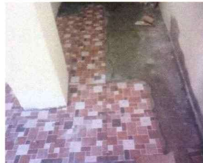
Foto 6: Instalación de piso antideslizante
