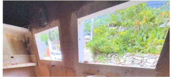
Foto 2: Sustrucción de ventanas
