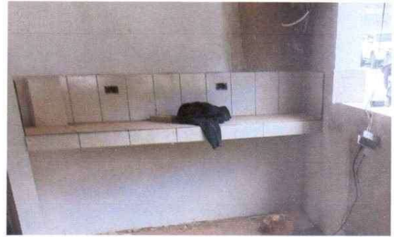
Foto 8: Sustitución de tomacorrientes.
