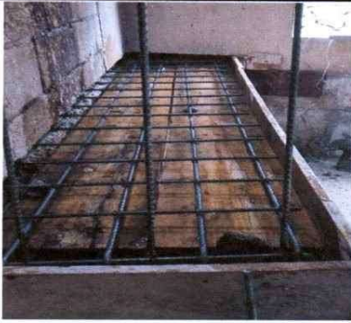
Foto 7: Suministro e instalación de mesas de trabajo de cocina.
