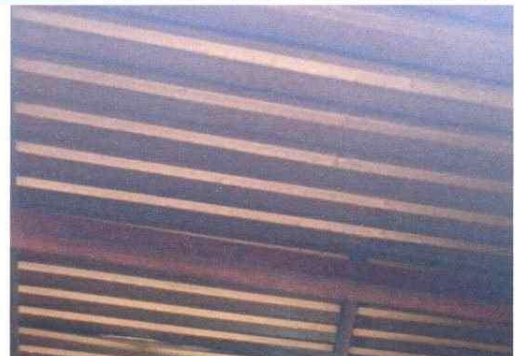
Foto 4: Mantenimiento de estructura y lamina con pintura anticorrosiva.
