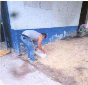
Foto 9: Sustitución de torta de concreto de patio.
