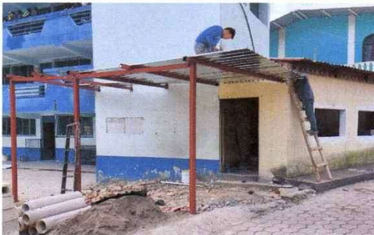
Foto 11: Sustitución de lámina troquelada calibre 26.
