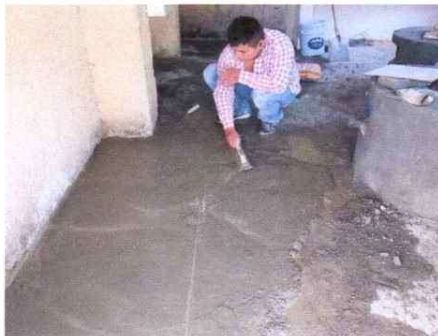
Foto 5: Sustrucción de piso de concreto de cocina
