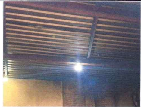
Foto 10: Sustitución de estructura portante de techo de cocina.
