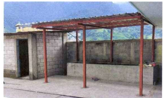
Foto 12: Suministro e instalación de lavamanos y techo.
