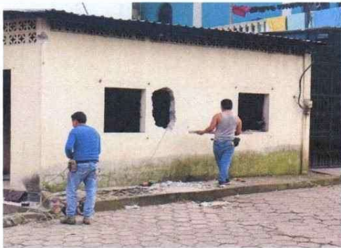
Foto 3: Sustrucción de balcones
