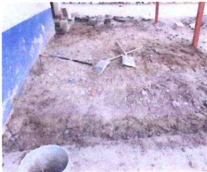
Sustitución de torta de concreto de patio.
