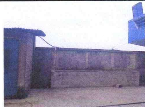
Suministro e instalación de lavamanos y techo
