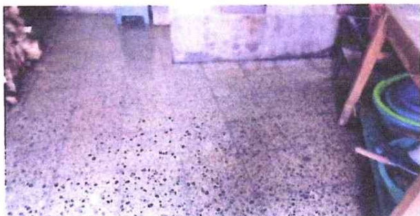
Sustitución de piso de concreto de cocina
