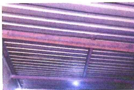
Mantenimiento de estructura y lamina con pintura anticorrosiva
