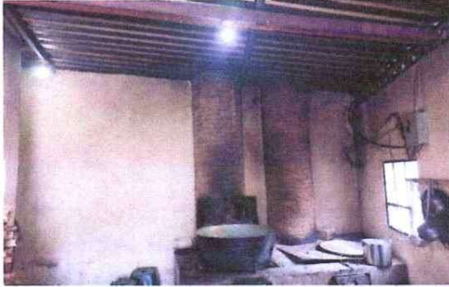
Suministro e instalación de mesas de trabajo de cocina
