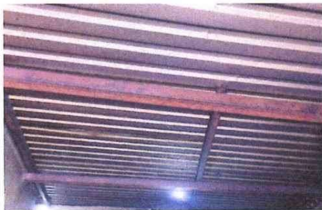
Sustitución de lamina troquelada calibre 26
