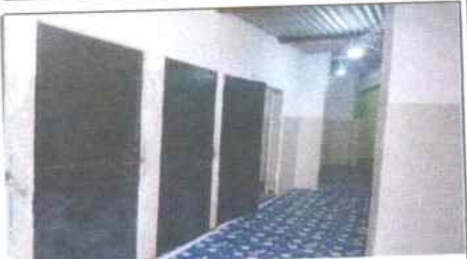
Foto 4: Sustitución de puerta de metal
