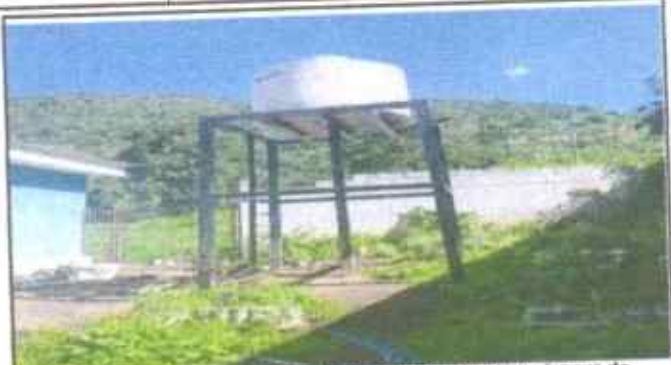
Foto 2: Suministro e instalación de torre de estructura para tanque de agua potable+ instalación de tubería.
