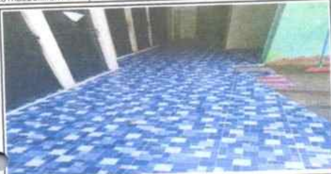
Foto 1: Mantenimiento general de módulo de servicios sanitarios
