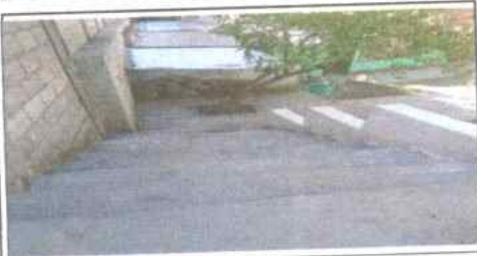
Foto 3: Suministro e instalación de gradas de acceso
