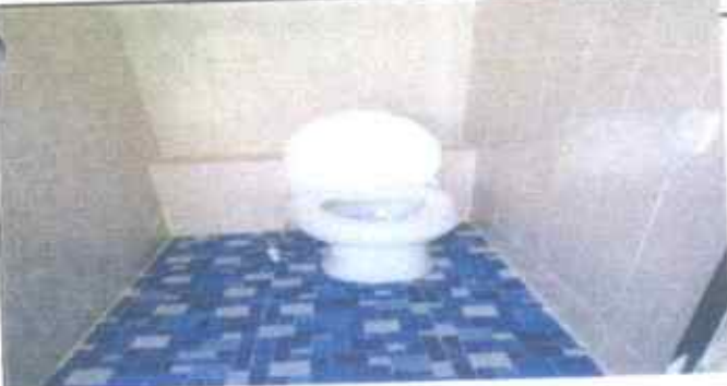
Foto 5: Sustitución de inodoros.
