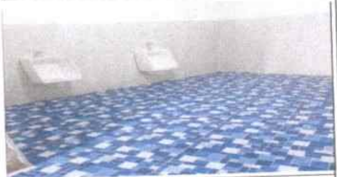
Foto 6: Sustitución de mingitorios.
