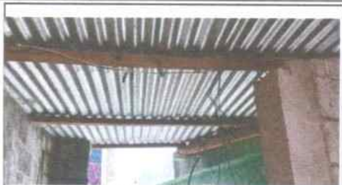
Foto 8: Sustrucción de estructura soporte de techo de lamina modulo de baños.
