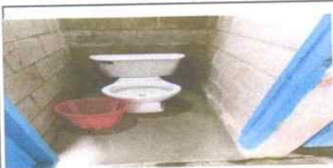
Sustitución de inodoros
