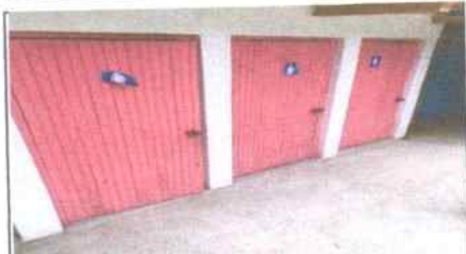
Sustitución de puertas de metal
