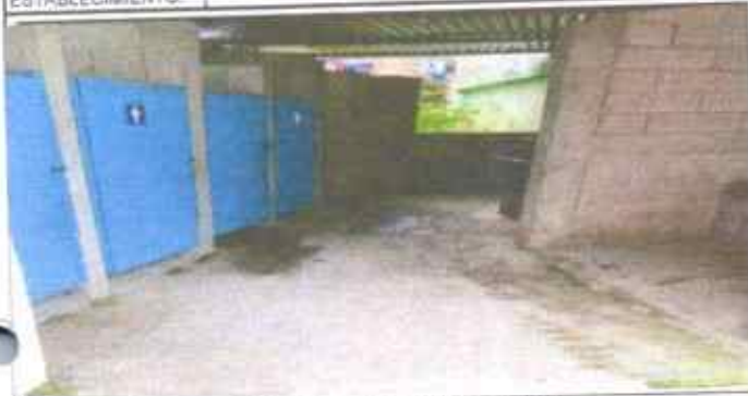
Mantenimiento general de modulo de servicios sanitarios
