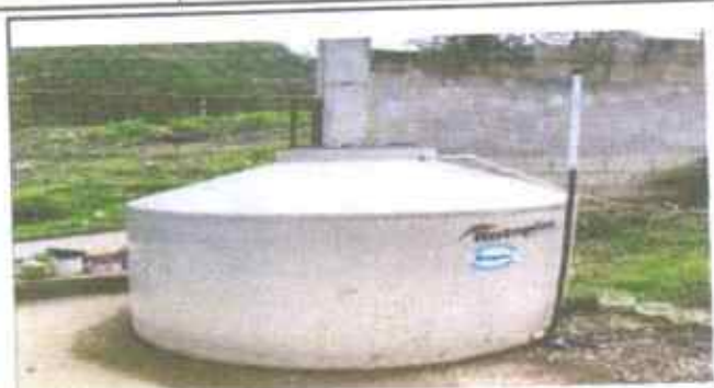
Suministro e instalación de torre de estructura para tanque de agua potable + instalaciones de tubería
