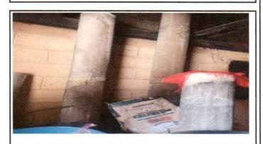
Suministro e Instalación de chimenea de tubo de 8 pulgadas de cemento debidamente inastalados para la extracción de humo.
