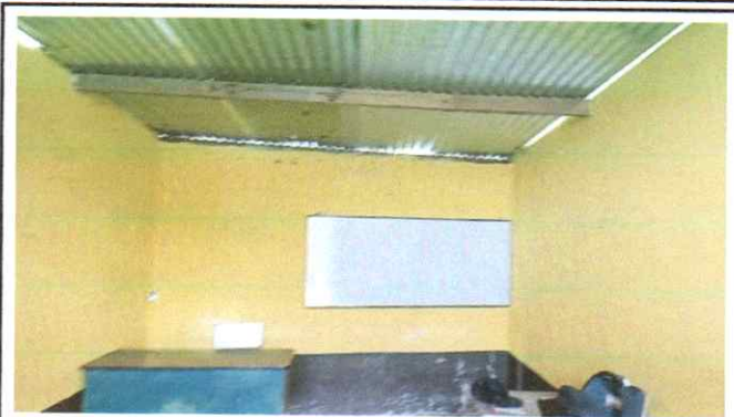
CAMBIO DE TECHOY ESTRUCTURA PORTANTE
