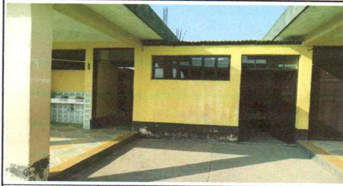
CAMBIO DE TECHOY ESTRUCTURA PORTANTE
