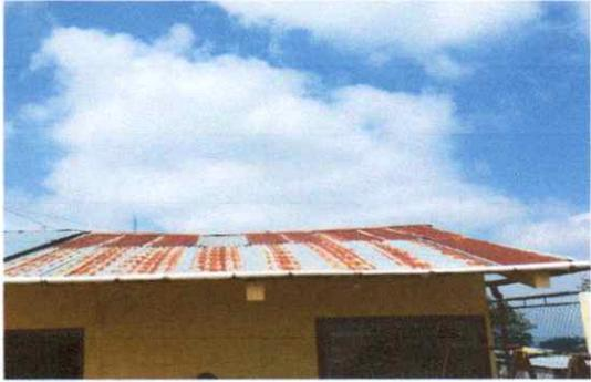
Sustitución de lamina por lamina troquelada calibre 26, sustitución de estructura de soporte de madera por metal galvanizado y sustitución del sistema electrico.
