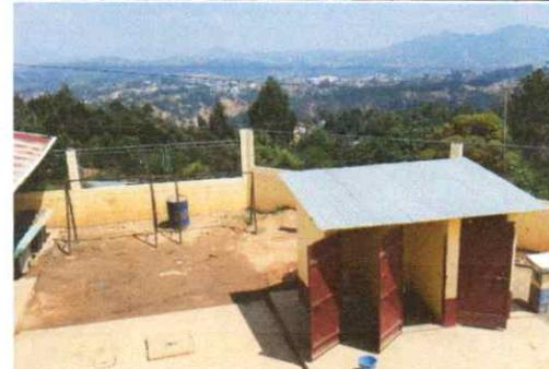
Sustitución de torta de concreto de patio y sustitución de paredes de baños por paderes de mamposteria pineado, cizado y alizado el interior.
