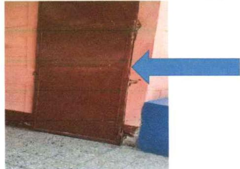
Las puertas se encuentran en mal estado es necesario la reparación, lijado, pintado y cambio de chapa.
