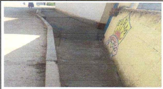
Reparación de banqueta (Corte de piso de concreto, excavación, relleno y compactación de suelo)
