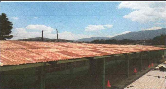
Cambio de techo modulo II con lámina de zinc calibre 0.24
