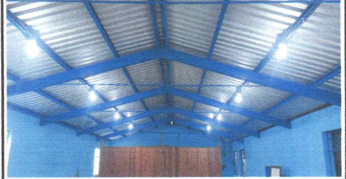
Cambio de estructura portante e instalación eléctrica
