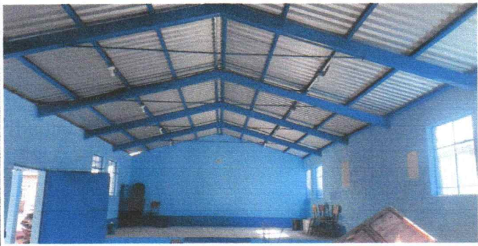
Cambio de estructura portante
