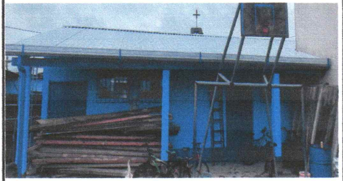
Instalación de canales y bajadas de agua
