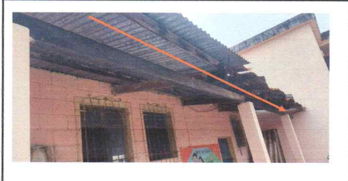
Sustitucion de lamina troquelada calibre 26
