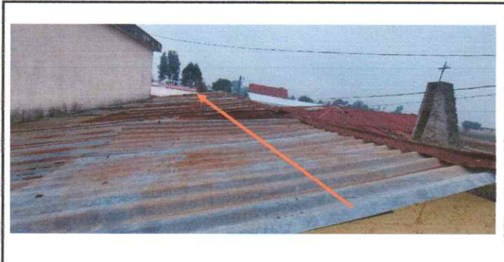
Sustitucion de lamina troquelada calibre 26
