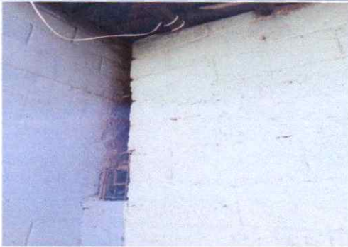
Suministro y mano de obra de terminación de columna 1.50 * 25
