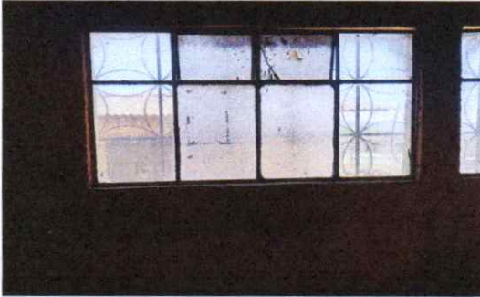
Suministro e instalación de ventanas de aluminio corredizo de vidrio de color bronce de 5 milímetros de grueso (con medida de 1.50 * 85 cm)
