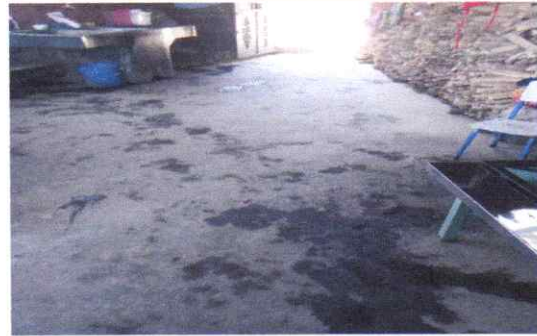
Suministro e instalación de piso cerámico antideslizante marca hispacensa con su adhesivo y sisa.
