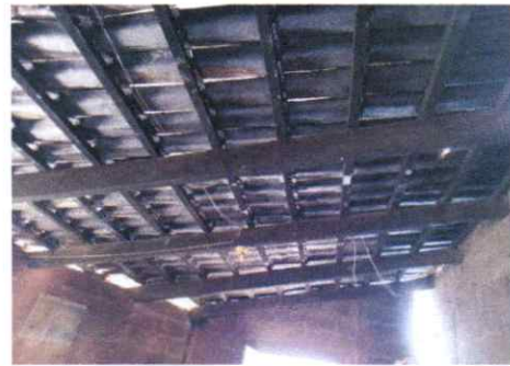
Desinstalacion de techo e instalación de lamina troquelada Aluzinc calibre 26, incluye tornillos de 2 pulgadas con pintura de roca de ferromax
