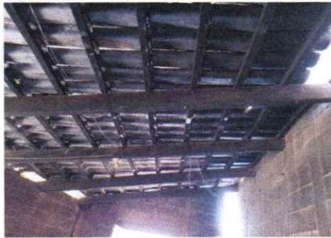
Mantenimiento de vigas existentes de madera (lijada y pintada)
