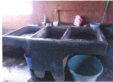
Lavaderos de 60 cm. Cada lado con su fosa de agua y su estantería, e instalación de tubo de agua en pila de concreto con su chorro.
