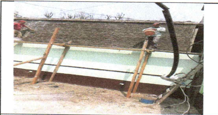
Foto 3: Extensión de muro aula 1
