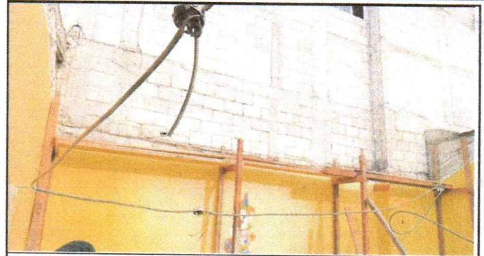
Foto 2: Extensión de muro aula 2
