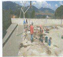
Sustitución de piso de concreto
