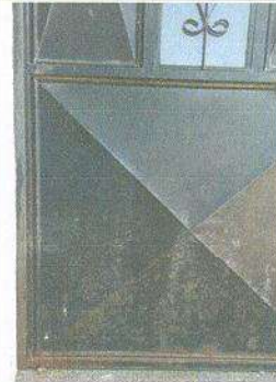
Mantenimiento de puerta metal
