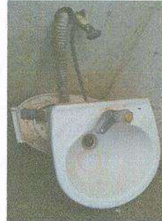
Mantenimiento de lavamanos
