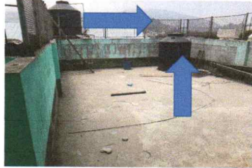
Suministro e Instalación Muro Lamina Troquelada
