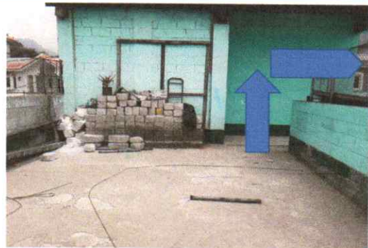
Suministro e Instalación Ventaneria. Suministro e Instalación Puerta Metálica
