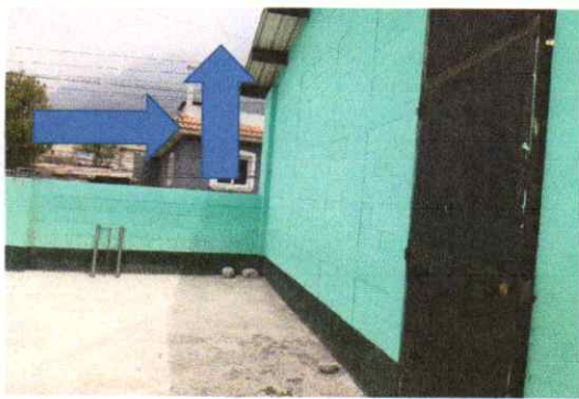
Suministro e Instalación Iluminación
