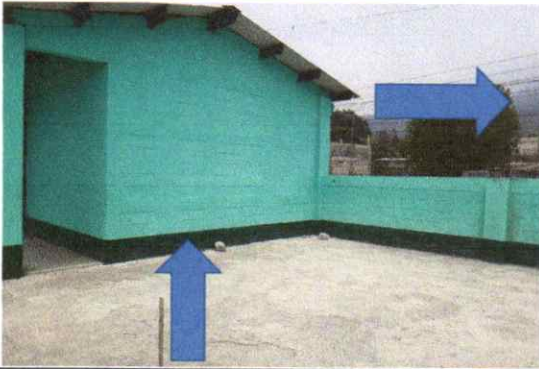
Suministro e Instalación Estructura Metalica. Suministro e instalación paneles y muro
