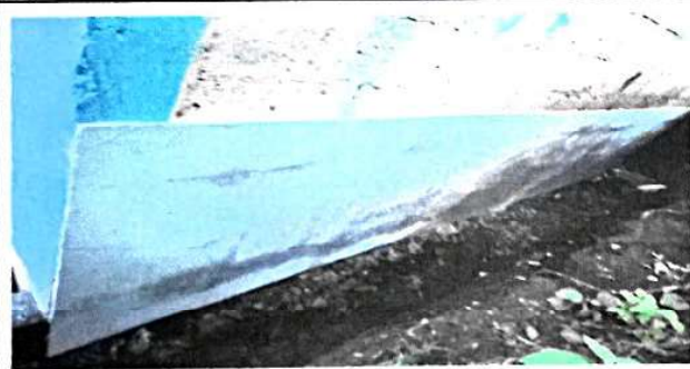
Foto 3: Finalización de colocación de impermeabilizante para muros.
