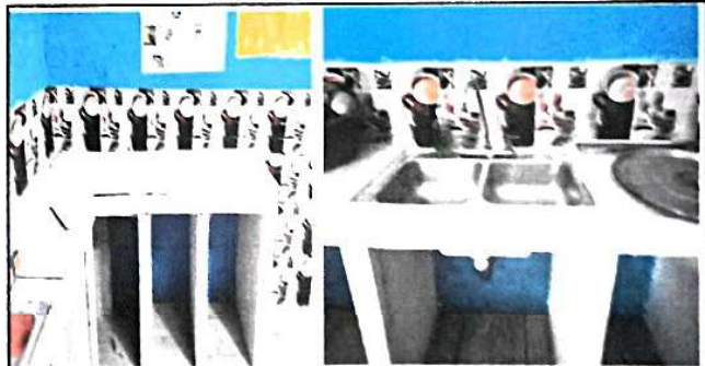
Foto 4: finalización de colocación de piso ceramico, azulejo en mesas de cocina y lavatrastos.
