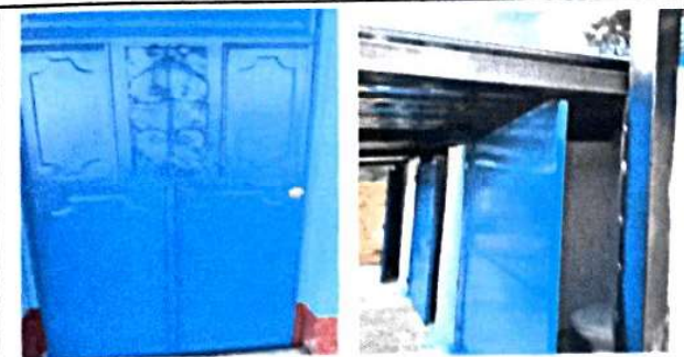
Foto 5: finalización de reparación de puertas y cambio de chapas.
