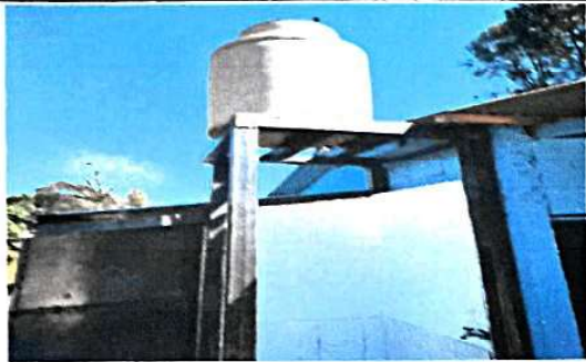
Foto1: Finalización de base metálica e instalación de tinaco.
