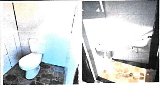
Foto 2: finalización de sustitución de muros divisorios de baños.
