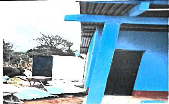
Foto 2: Proceso de reparación de muros divisorios de sanitarios.
