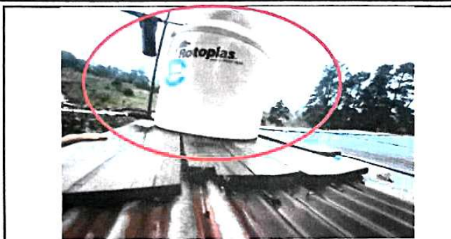
Foto 1: sustitución de tanque de almacenamiento de agua (tinaco)
