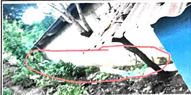
Foto 3: suministros e instalación de material aislante o impermeable para muros
