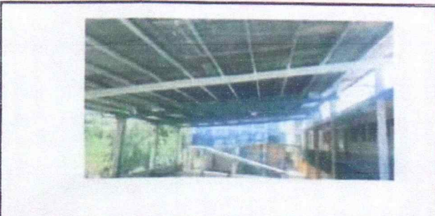
Foto 5: Vista de techo desde el ingreso
