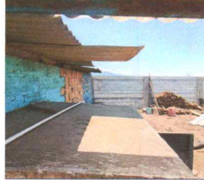
suministro y fabricación de pestaña con lamina troquelada calibre 26
