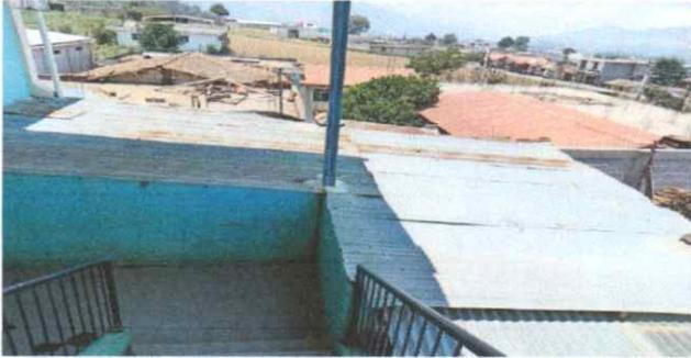
Suministro e instalación de lámina troquelada calibre 26 con dos costaneras 4x2 para soporte , Suministro e instalacion de lamina troquelada calibre 26 a cocina
