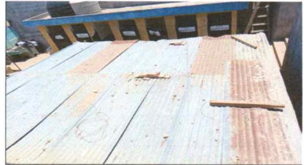
Suministro e instalación de lámina troquelada calibre 26 con dos costaneras 4x2 para soporte
