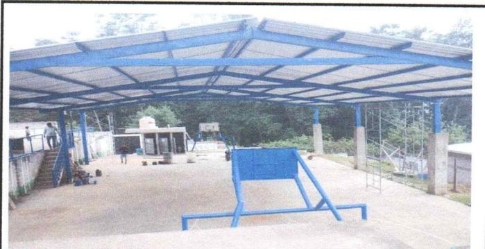
Foto 6: INTERIOR DE LA CANCHA CON SUMINISTRO E INSTALACIÓN DE LAMINAS FINALIZADO
