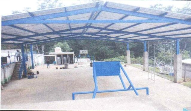
Foto1: VISTA FACHADA INTERIOR LAMINA COLOCADA AL 100%
