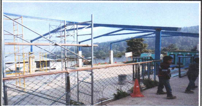
Foto 2: SUMINISTRO E INSTALACIÓN DE ESTRUCTURA.
