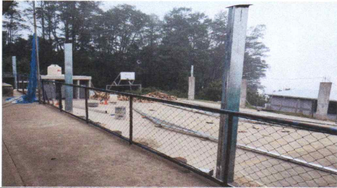
Foto1: Instalación de columnas.
