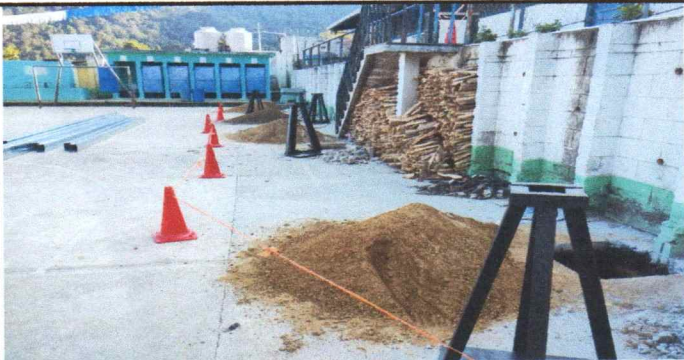
Foto 5: ANTES DE COLOCAR COLUMNAS
