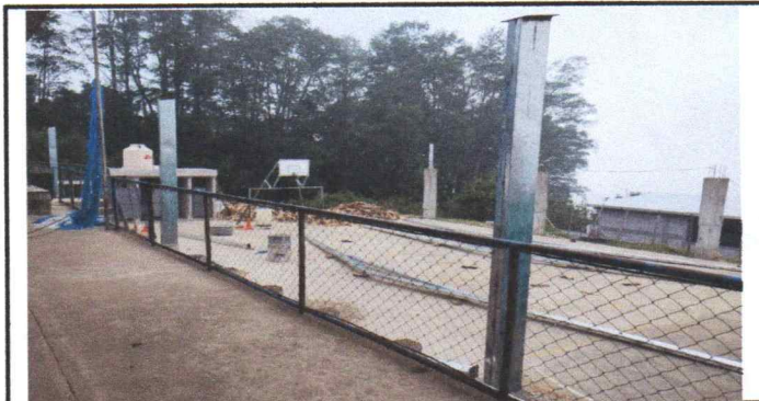
Foto 6: ANTES DE ENTECHADO
