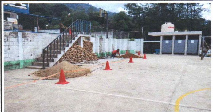
Foto 4: INSTALACION DE ZAPATAS
