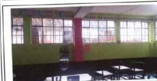
Foto 5: suministro e instalación de vidrios + pintura anticorrosivo
