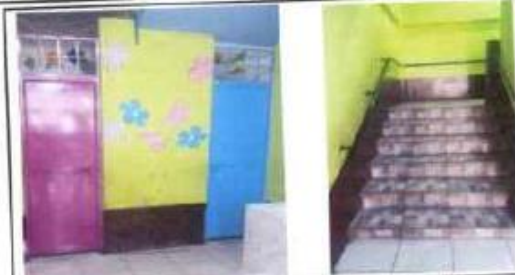
Foto 2: Suministro e instalación de puertas+ chapa, suministro e instalación de pasamanos
