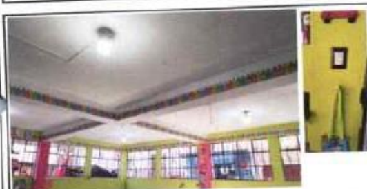
Foto 3: reparación de red electrica
