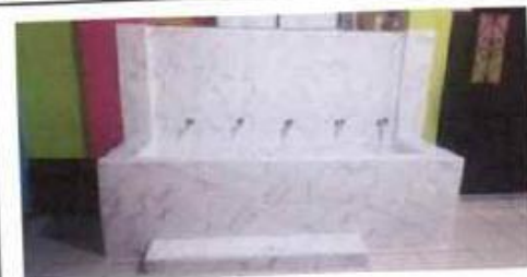
Foto 4: suministro y sustitución de azulejo para lavamanos
