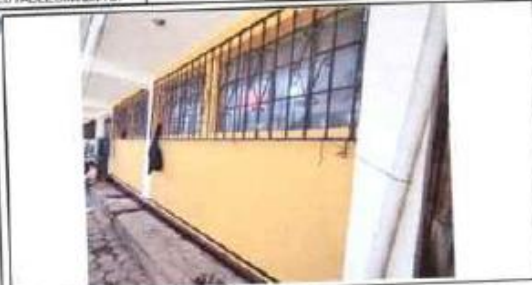
Foto 1: pintura en muros
