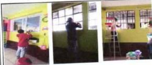
Foto 5: suministro e instalación de vidrios + pintura anticorrosiva
