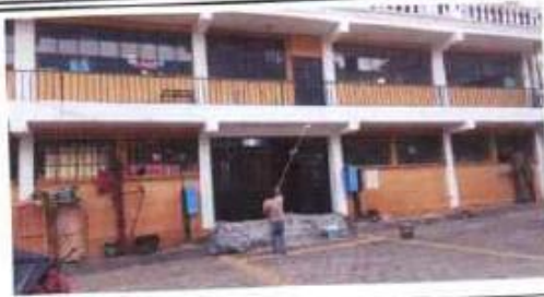
Foto 1: pintura en muros
