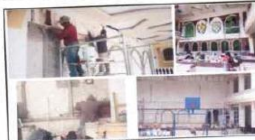
Foto 6: Sustitución de muro del escenario
