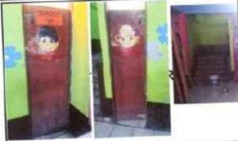
suministro e instalación de puertas de metal + chapa
