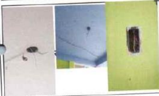
Reparación de la red eléctrica
