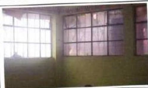
suministro e instalación de vidrios + pintura anticorrosivo
