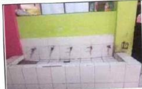
Suministro y sustitución de azulejo para lavamanos
