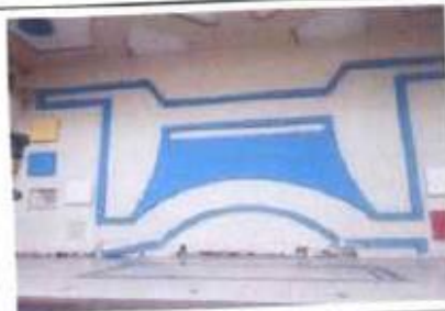
Sustitución de muro del escenario
