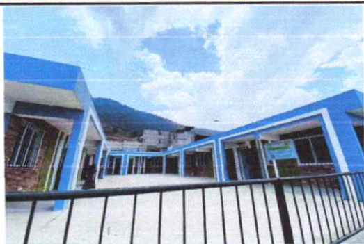
Estructura de techo y entechado de patio entre modulo 1 y 2
