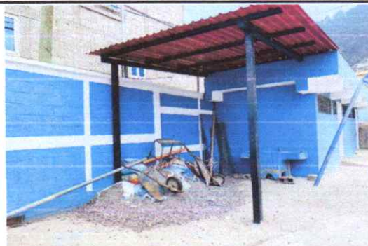
Remozamiento de estructura e instalacion de bodega.
