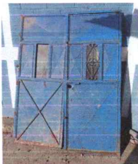
Remozamiento e instalación de puerta de metal en bodega.
