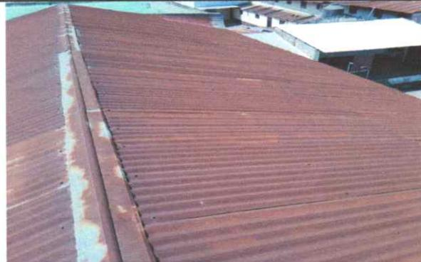
Sustitución de lámina por lámina troquelada calibre 26
