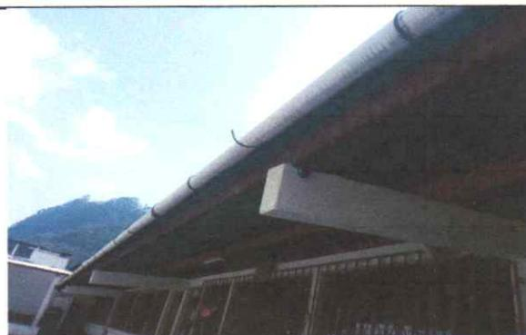
Sustitucion de canales de agua pluvial
