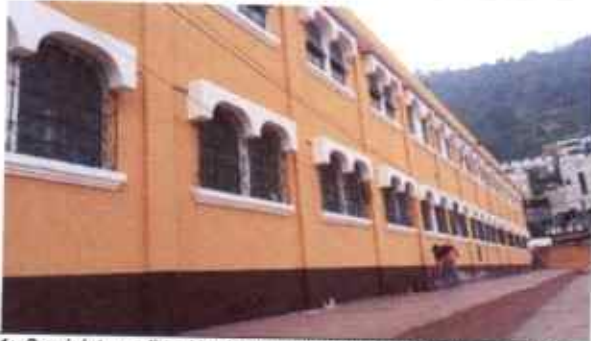
Foto1: Suministro aplicación de pintura en muros exteriores e interiores
