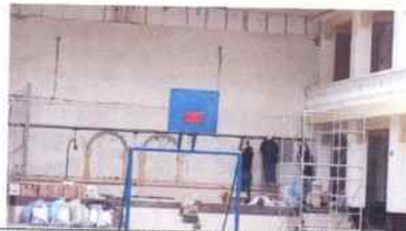
Foto 6: Sustitución de muro divisorio de material de tablayeso por fachal fachaleta
