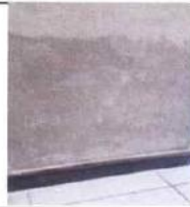
Foto 4: Mantenimiento en muro
