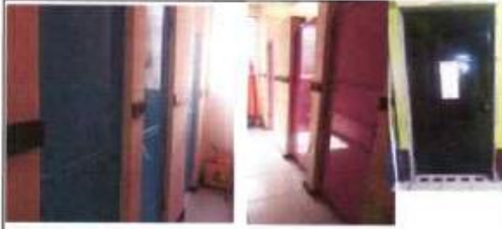
Foto1: Suministro e instalación de puerta de metal+chapa
