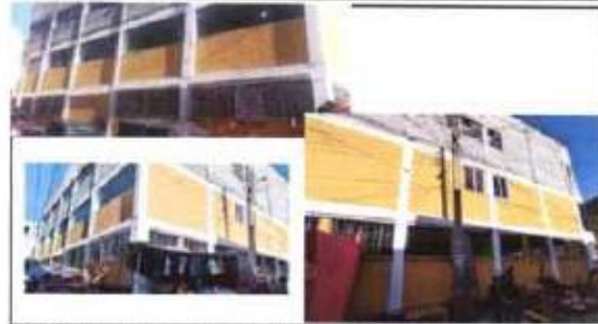
Foto 2: Suministro y aplicación de pintura en muros.
