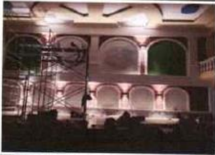
Sustitución de muro del escenario
