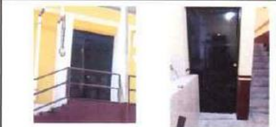
Foto 5: Sustitución e instalación de puertas de metal + chapa
