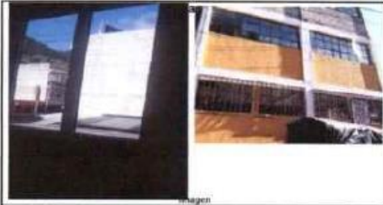
Foto 3: Mantenimiento de estructura de ventana y suministro e instalación de vidrios
