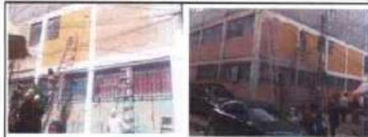
Foto 2: suministro y aplicación de pintura en muros
