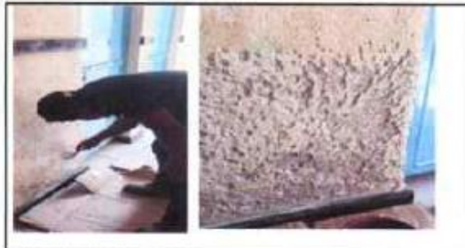
Foto 4: Mantenimiento en muro
