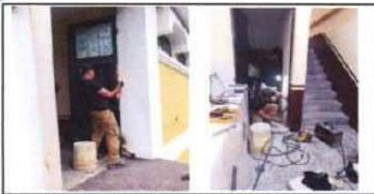
Foto 5: Sustitución e instalación de puertas de metal + chapa
