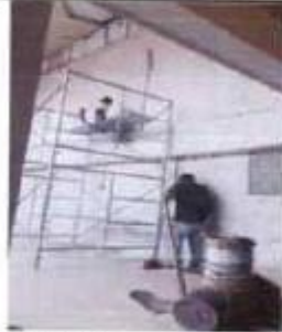
Sustitución de muro del escenario
