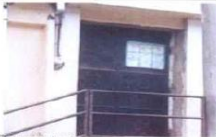
reparación de puertas de metal
