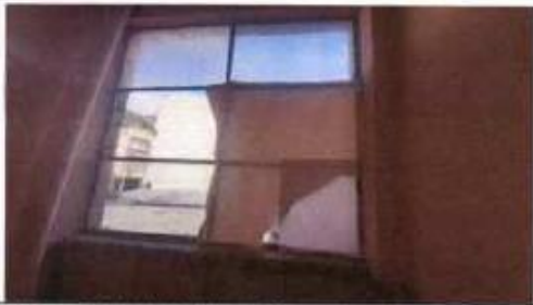
suministro e instalación de vidrios + pintura anticorrosivo
