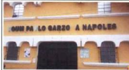
suministro e instalación de letras con material concreto
