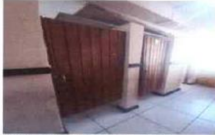
suministro e instalación de puerta de metal + cbapa
