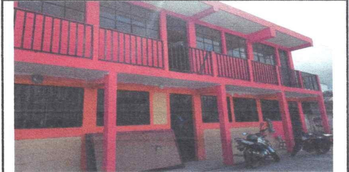
Foto 4: Aplicación de pintura en exterior e interior en muros
