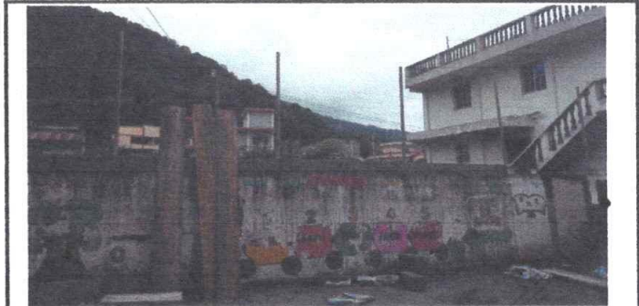
Foto 6: Sustitución de maya galvanizada
