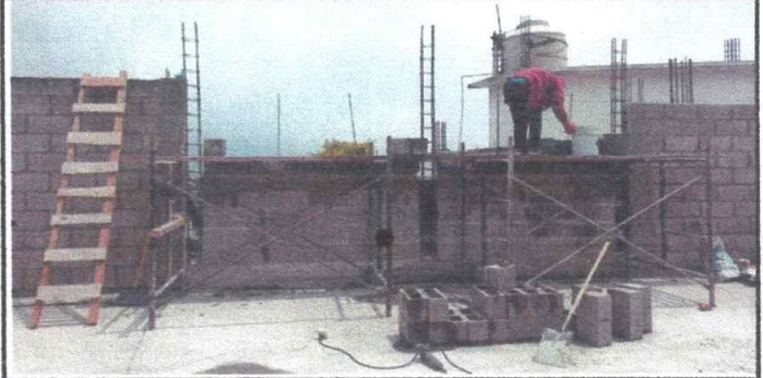
Foto 2: Levantado de pared nueva
